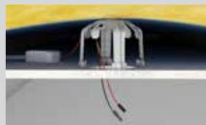
L'écarteur est stable sur le revêtement et assure la distance nécessaire à l'isolation.
