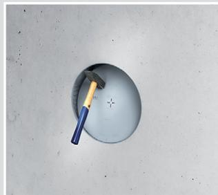
Nach dem Entschalen das Frontteil mit einem Hammer schlag öffnen (z. B. 1282-65).
