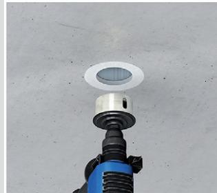
Einfaches und variables Erstellen der Installationsöffnung im Universalfrontteil mit z. B. 1083-10.
