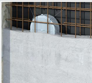
Nach dem Stellen der Gegenschalung kann betoniert werden.
