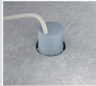
Das komplette Gehäuse mit eingebrachtem Installationsrohr wird nun in die Aussparung bzw. Kernbohrung eingesetzt und auch...
